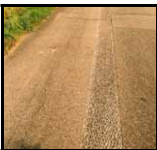
Удаление дорожной разметки / Demarking
