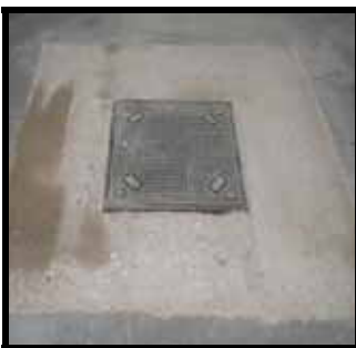
Фигурное фрезерование- квадрат / Square milling
